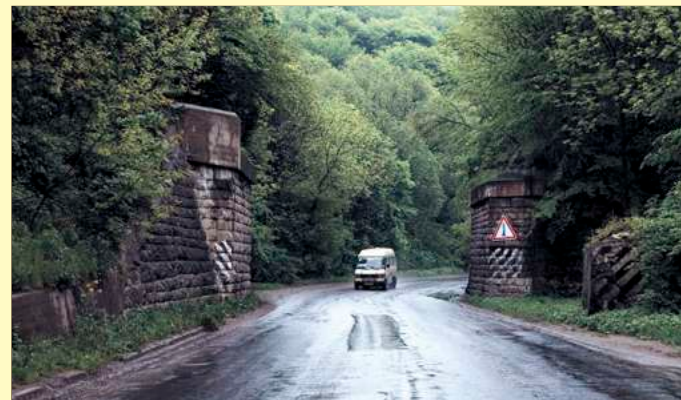
ФРАГМЕНТ ЗАЛІЗНИЧНОГО МОСТА, XIX ст. Фото Іллі Левіна FRAGMENT OF A RAILWAY BRIDGE, XIX c. Photo by Illia Levin
